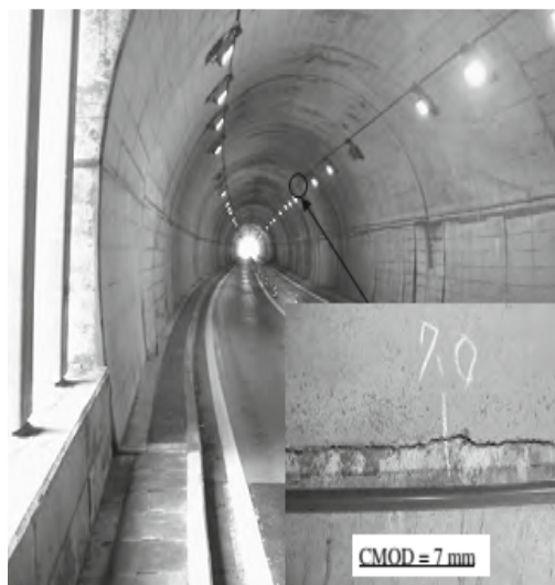
Gambar 2. Contoh Retakan di Terowongan Sumber : Shi (2009)
